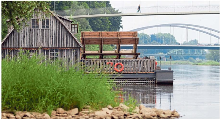
Die Schiffmühle kann seit Pfingstsonntag wieder besichtigt werden – allerdings mit Einschränkungen.
